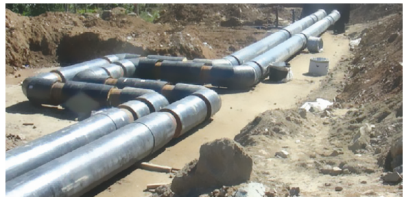
Şəkil 2 Boruların “Π” formasında birləşdirilmiş hissəsi
